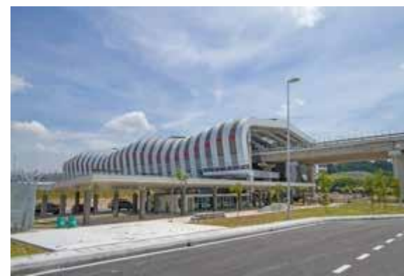
PUTRA HEIGHTS 轻快铁站
